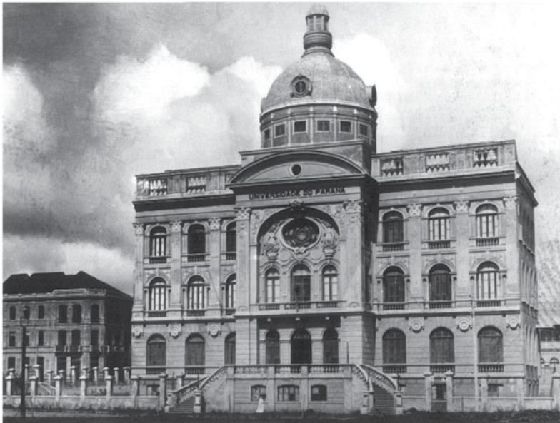
Primeira parte concluída do prédio da Universidade do Paraná, 1918. Acervo: Reitoria UFPR / Col. Cid Destefani
