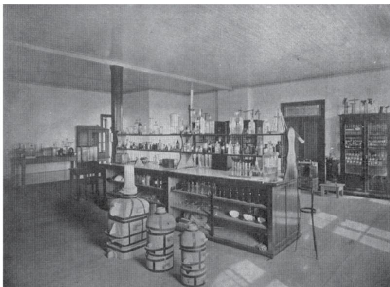
Laboratório de Química Geral, 1915. Acervo: Biblioteca Central
