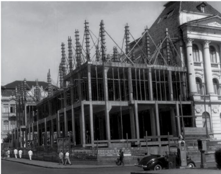
Construção da ala voltada à Rua XV, 10/1940.
