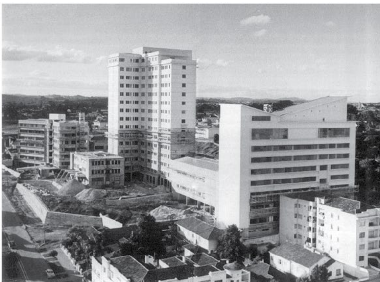
Hospital de Clínicas parcialmente concluído.
